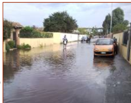
Via Salorno, allagata. Spettacolo usuale, spesso arricchito dal traffico, all'uscita della scuola.
